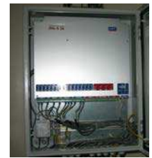
Gama de sensores SKF monitoreando puntos definidos y sistema de vigilancia en línea SKF IMx
